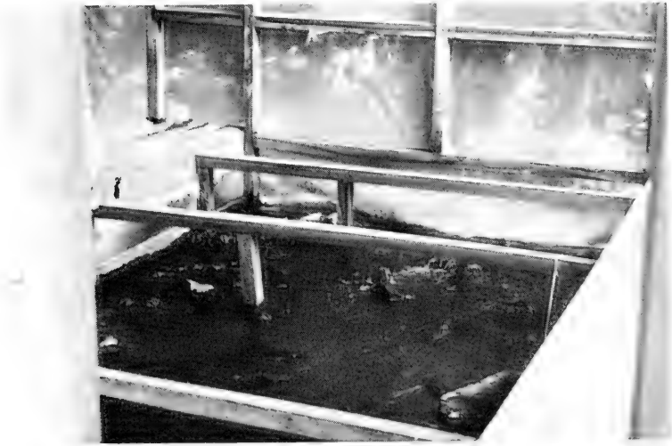
Abb. 4 Emergenzhaus, Innenansicht bachaufwärts.
